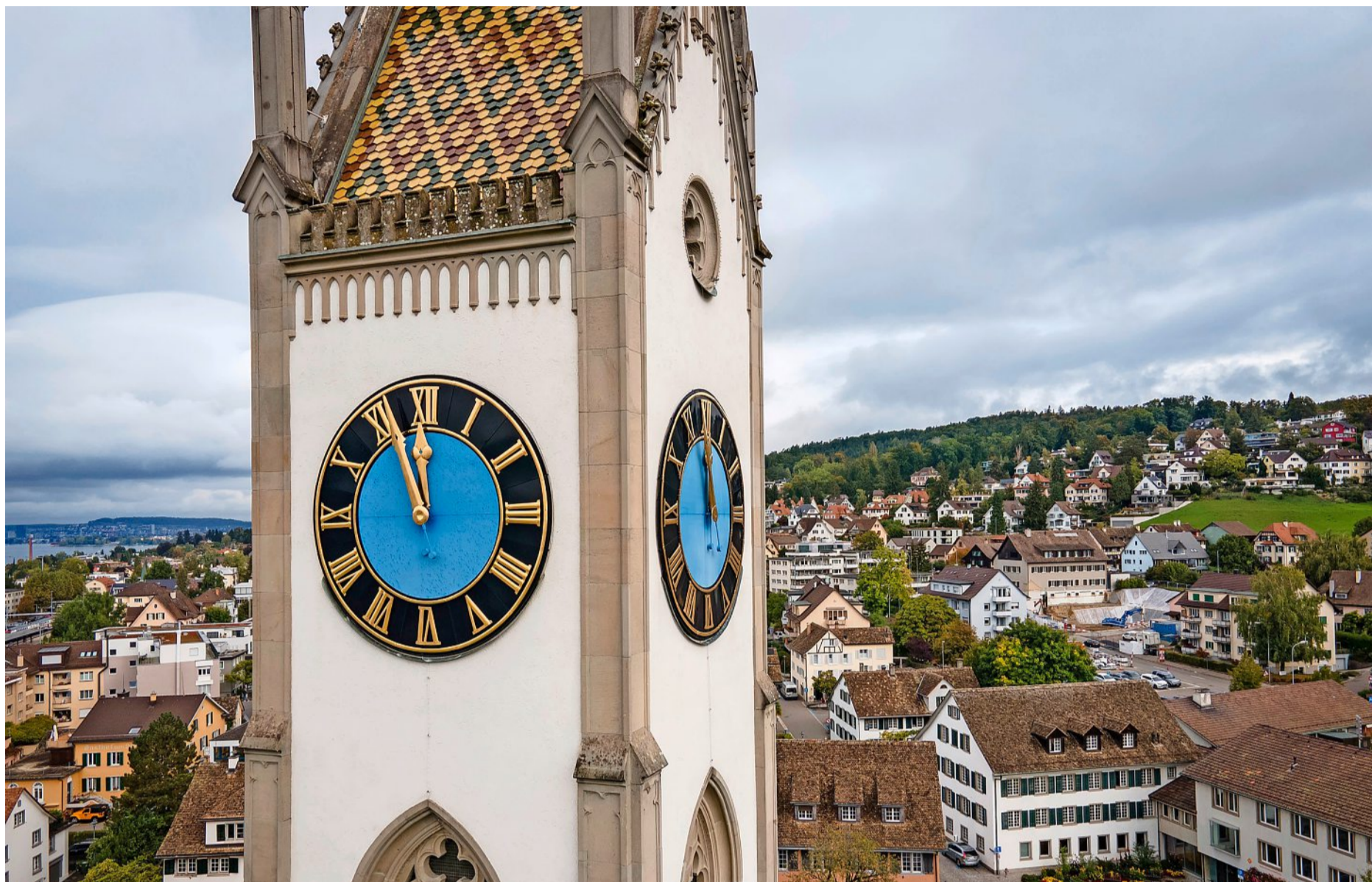
Die Reparaturen an der defekten Turmuhr der reformierten Kirche Küsnacht könnten noch bis Weihnachten dauern. Foto: Michael Trost
